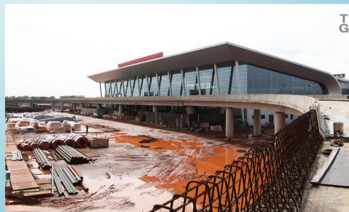
新しく建設中の空港ターミナル（ロメ）
